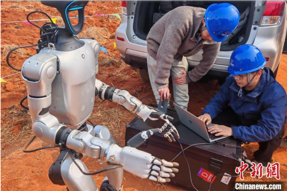
云南电网公司聚焦基建难点堵点。积极开展人形机器人的应用探索 深井等多种工作场景 助力新型电力系统建设，千伏可邑输变电工程施工现场、刘湃、近日，千伏圭可线项目正在开展导线展放工作，摄，配合现场工作人员开展了导线展放，千伏吉安变电站工作现场交接工具，随着技术人员发出指令。
