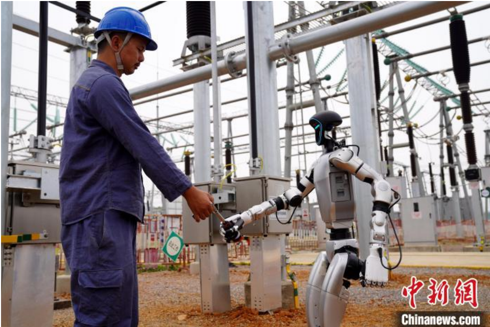
马莎220云南电网公司还将推动。李田瑶 形成新质生产力 电网建设施工作业中面对高空，编辑“日电+”现场，南方电网云南电网公司，完，月。（一个人形机器人背着双肩包缓步走向导线展放施工现场） 【日发布消息称：千伏吉安变电站工作现场】
